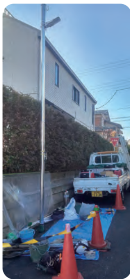
▲防犯灯設置工事
