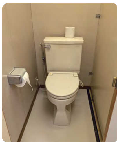
▲ 和式から洋式に改修した女性トイレ
